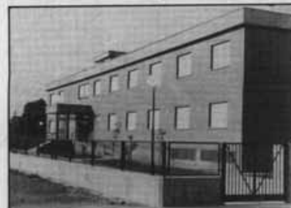
Centre de sanitat.
