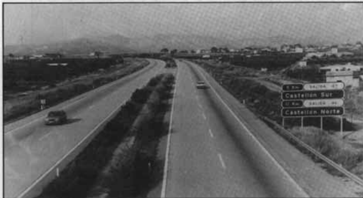
Autopista Girona-Alacant A-7.
